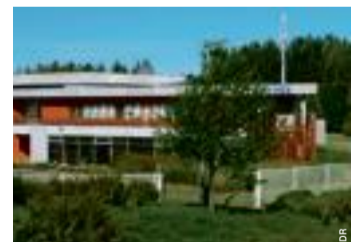
Le CRITT M2A sur le campus technologique de Béthune-Bruay.
