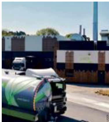
L'usine de méthanisation de LIGER.
